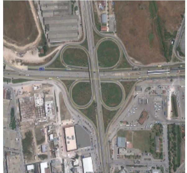
Çalı Köprülü Kavşağı
