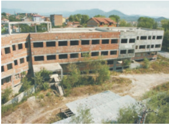
Al-Rahma Hastanesi İnşaatı üst görünüş
